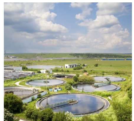
Sauberes Wasser dank hoher Anlagenverfügbarkeit
