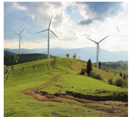
Geschützte Signalkreise in luftiger Höhe
