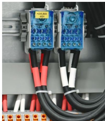
Weiß und Rot sind die Kennzeichen von Gleichstromanschlüssen
