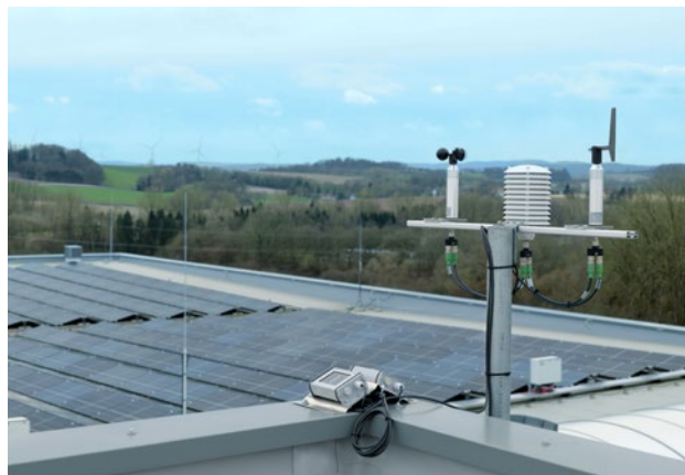
Eine ausgeklügelte Gebäudesteuerung arbeitet mit dem Energiemanagementsystem zusammen
