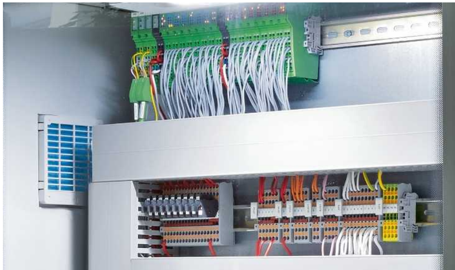
Afb. 11: Aansluittechniek aan de voorzijde met eenzijdige kabel aansluiting en aan beide zijden aderaansluiting in kabelgoten
