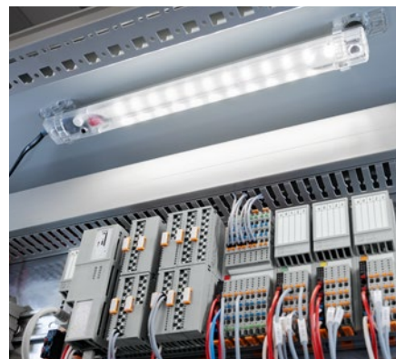
Luminaria estándar montada en el armario de control
