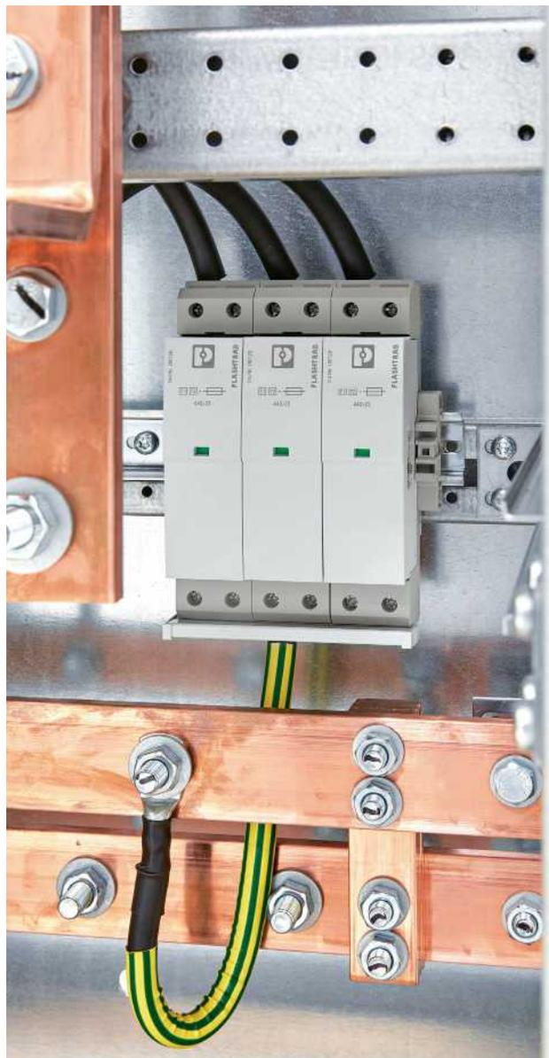
Descargador combinado contra rayos y sobretensiones de tipo 1+2 con fusible integrado
