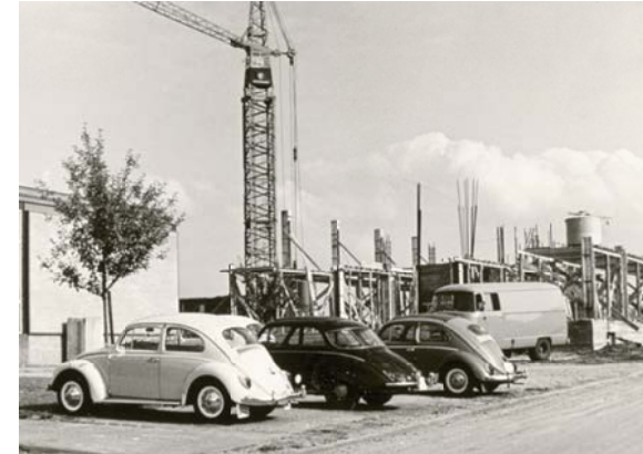
弗拉赫斯马克特工地上 热火朝天的施工作业
