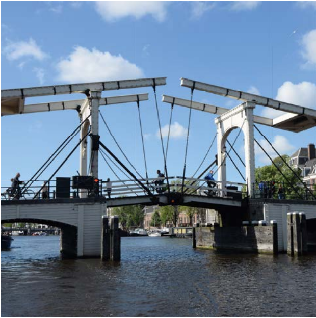
Zugbrücke im Straßenverkehr
