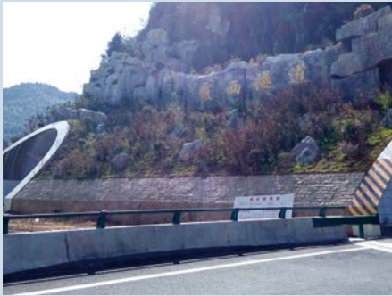
宁绩高速隧道监控系统
