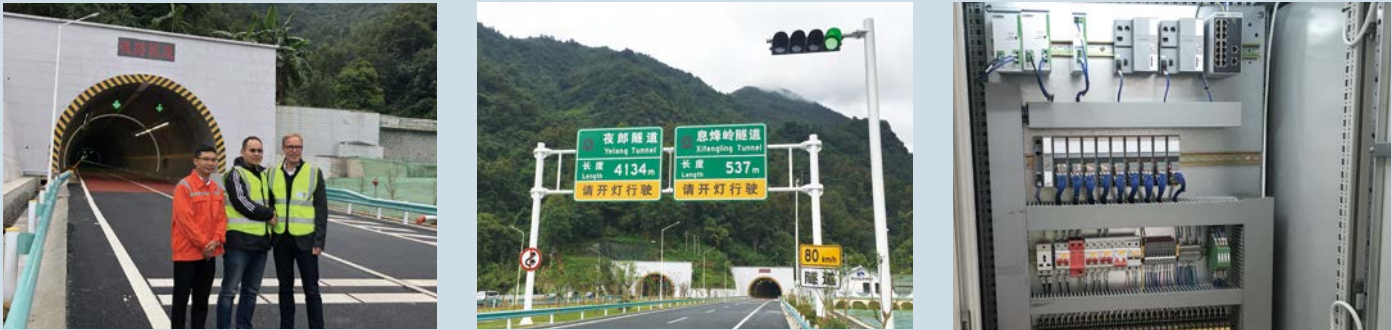
罗旺高速隧道 ASR 冗余监控系统
