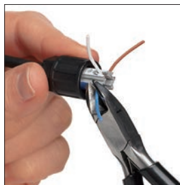
余分な電線を切断
