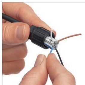
電線をガイドに固定
