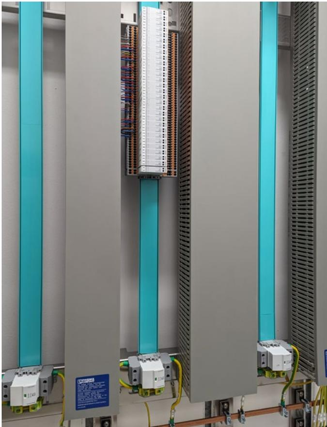
**Bild 4: Realisierung der isolierten Tragschiene**
