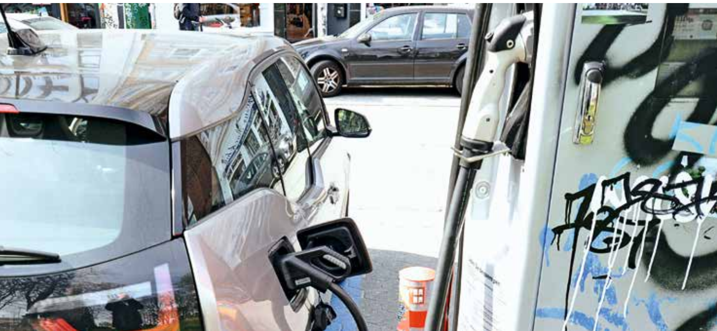
在2040年，涂鸦可能仍然是生活的一部分：汉堡Schanzeviertel区的公共充电站
