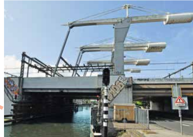
组合式桥梁形成了移动式交通路线
