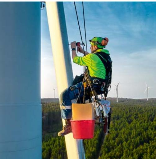
Damit Windrotoren nicht zu Eis-Weitwurfmaschinen werden
