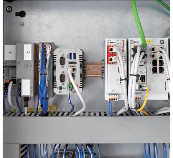
ネットワークセキュリティ、マネージドスイッチ エッジコンピュータ、I/Oシステム
