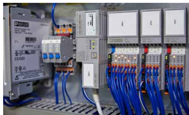
Cyber security er mere end bare at installere en firewall
