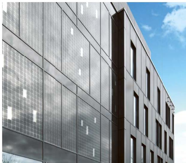
Innovación en los detalles: en los módulos de la fachada del lado sur se integran elementos fotovoltaicos
