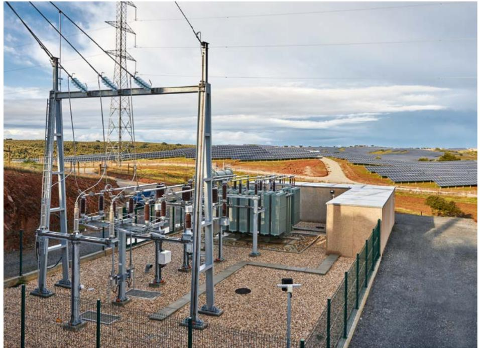
Netzanschlusspunkt der PV-Anlage in Moura, Portugal, mit der Einspeiseregulung von Phoenix Contact
