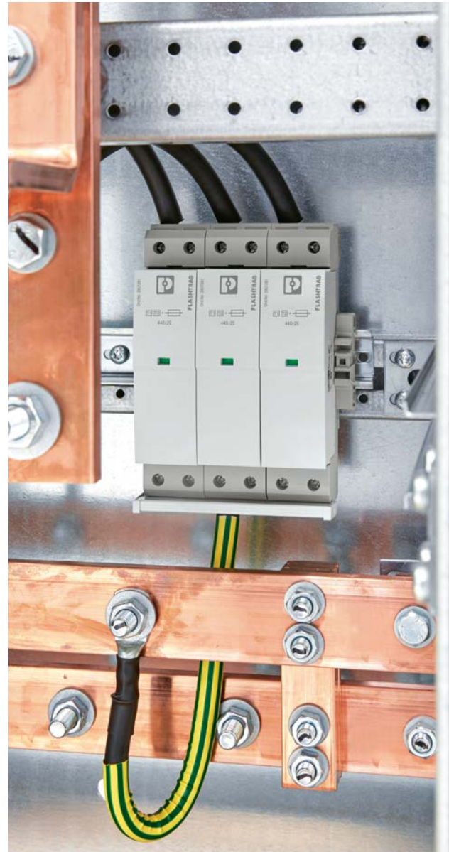
Kombiableiter Typ 1+2 mit integrierter Sicherung FLT-SEC-H-T1-3C-264/25-FM Art.-Nr. 2905871
