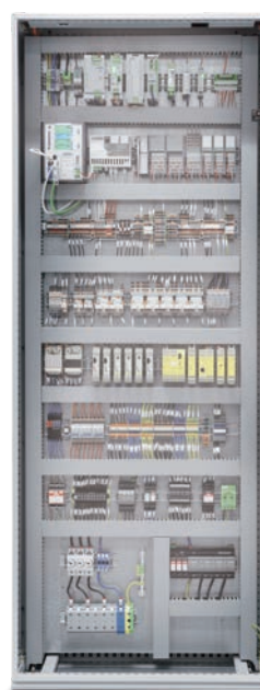
PLD制御盤用 LED照明
