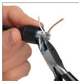
余分な電線の切断
