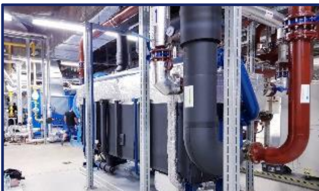
Wrocławski Park Technologiczny SAB-HW 021 G1
