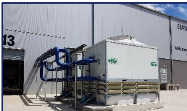
Eurometal - Walcownia wieże chłodnicze MCC
