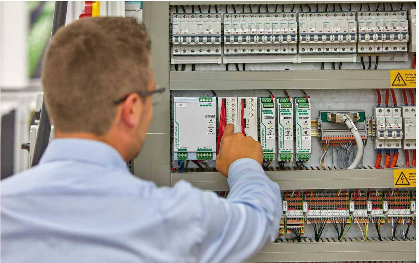
电子式设备断路器采用24 V DC开关电源供电。通常应用于机械制造、造船、系统制造和自动化技术等行业。故障情况下电流分析和快速脱扣功能可防止开关电源过载。从而保证开关式电源的输出电压不变，其他电路继续运行。该设备断路器是继电器、可编程控制器、马达、传感器、执行器和阀门等设备保护的理想选择。电子式设备断路器与开关电源配合使用，可提高系统和设备的可用性。
