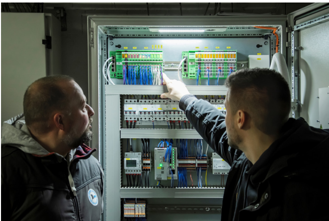
Pumper kontrolleres med den åbne ILC 2050 BI bygningscontroller
